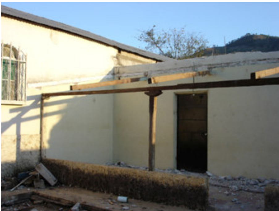
De reparatie van het kerkdak
