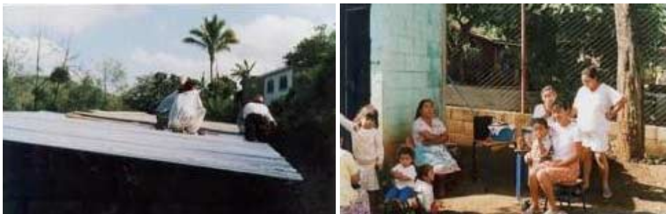
foto 3.2 – Reparatie aan het dak van de kleuterschool en de werkende moeders
